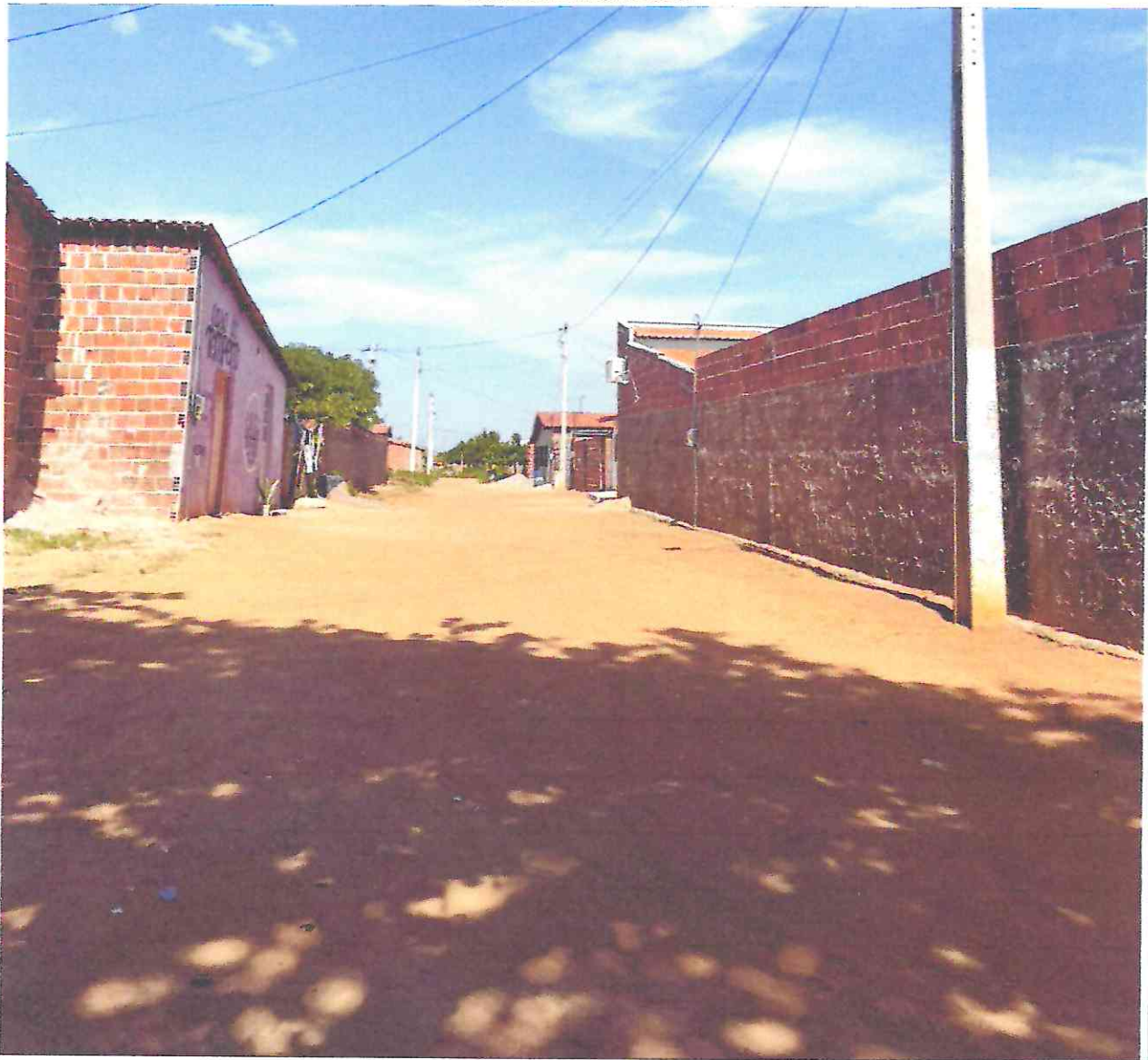
Figura 10: Rua II, Jatobá III, Barreira/CE
