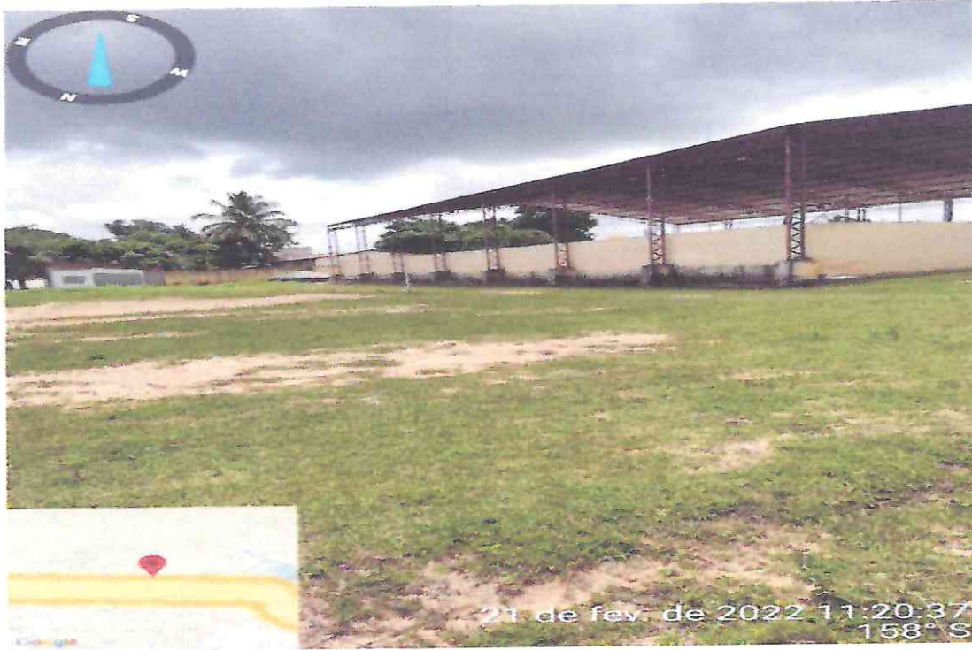
Figura 05: Campo de Futebol no Distrito de Córrego, Barreira-ce.
