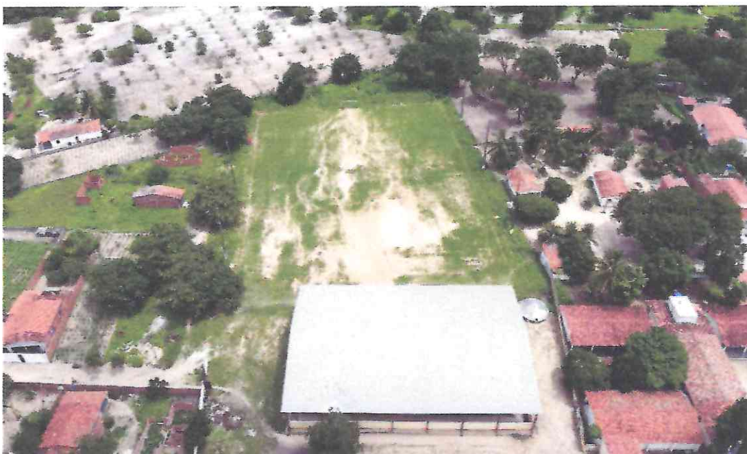
Figura 02: Campo de Futebol no Distrito de Córrego, Barreira-ce.
