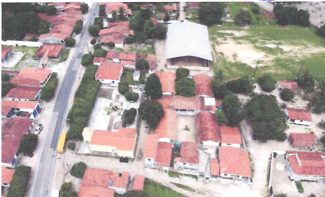
Figura 01: Campo de Futebol no Distrito de Córrego, Barreira-ce.
