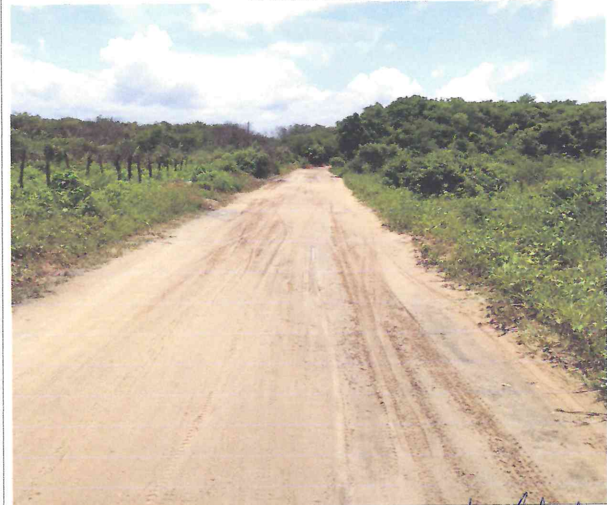
Figura 2: imagens do local da pavimentação
