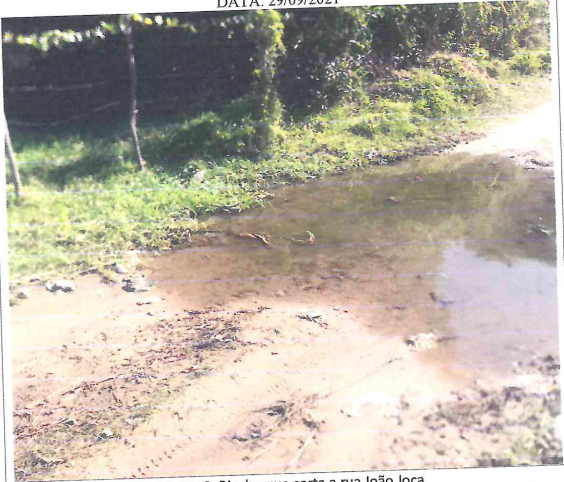
Figura 2: Riacho que corta a rua João Joca.
