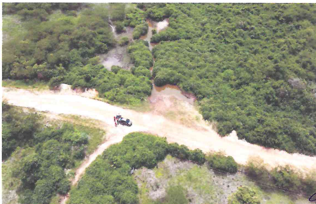
Foto 04: Construção de passagem molhada na localidade de Uruá, Barreira-CE.
