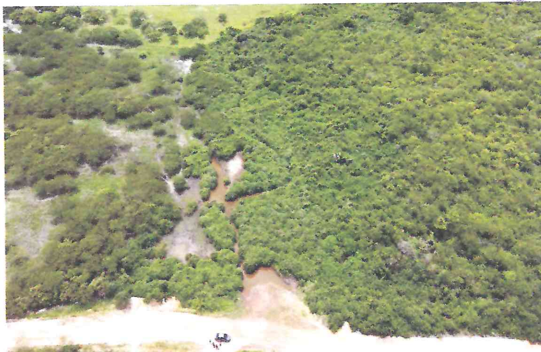
Foto 07: Construção de passagem molhada na localidade de Uruá, Barreira-CE.
