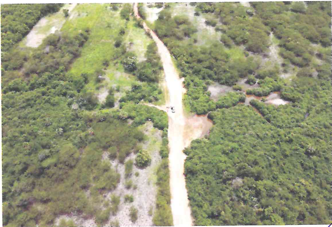
Foto 06: Construção de passagem molhada na localidade de Uruá, Barreira-CE.
