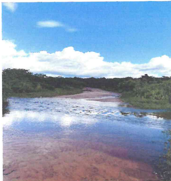
Foto 09: Construção de passagem molhada na localidade de Uruá, Barreira-CE.
