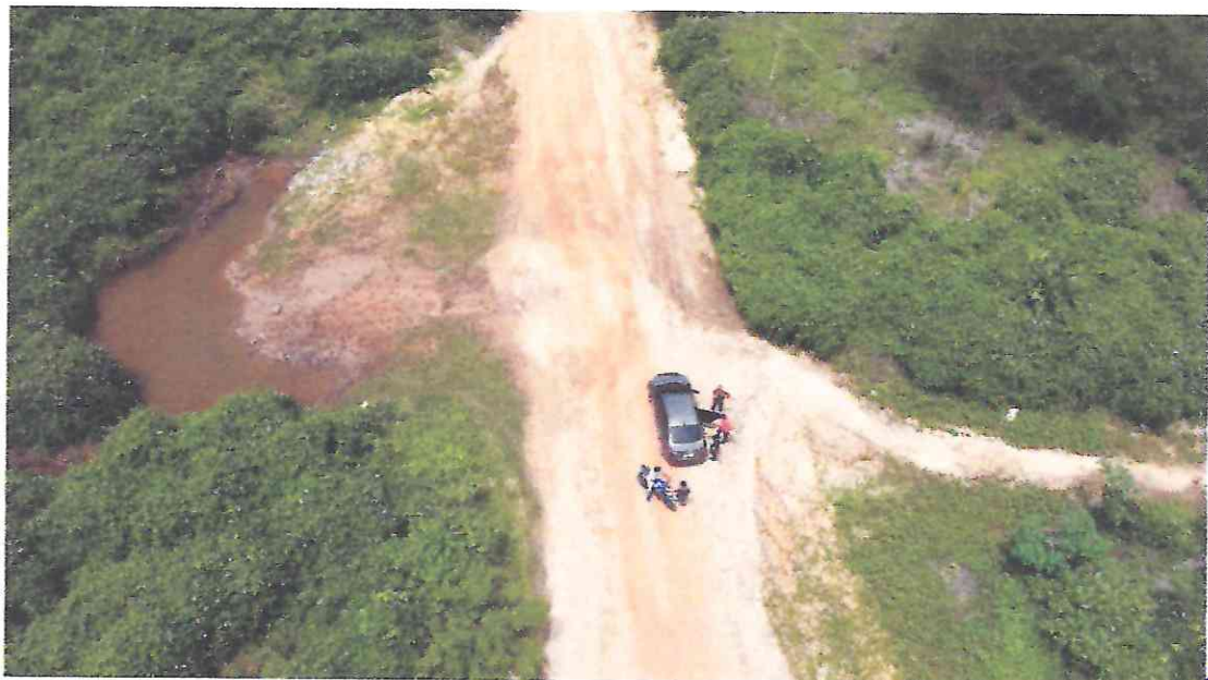
Foto 02: Construção de passagem molhada na localidade de Uruá, Barreira-CE.
