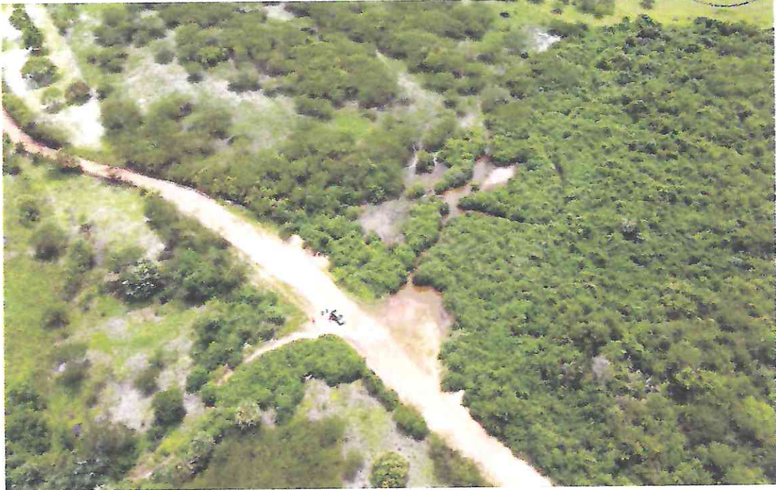
Foto 05: Construção de passagem molhada na localidade de Uruá, Barreira-CE.
