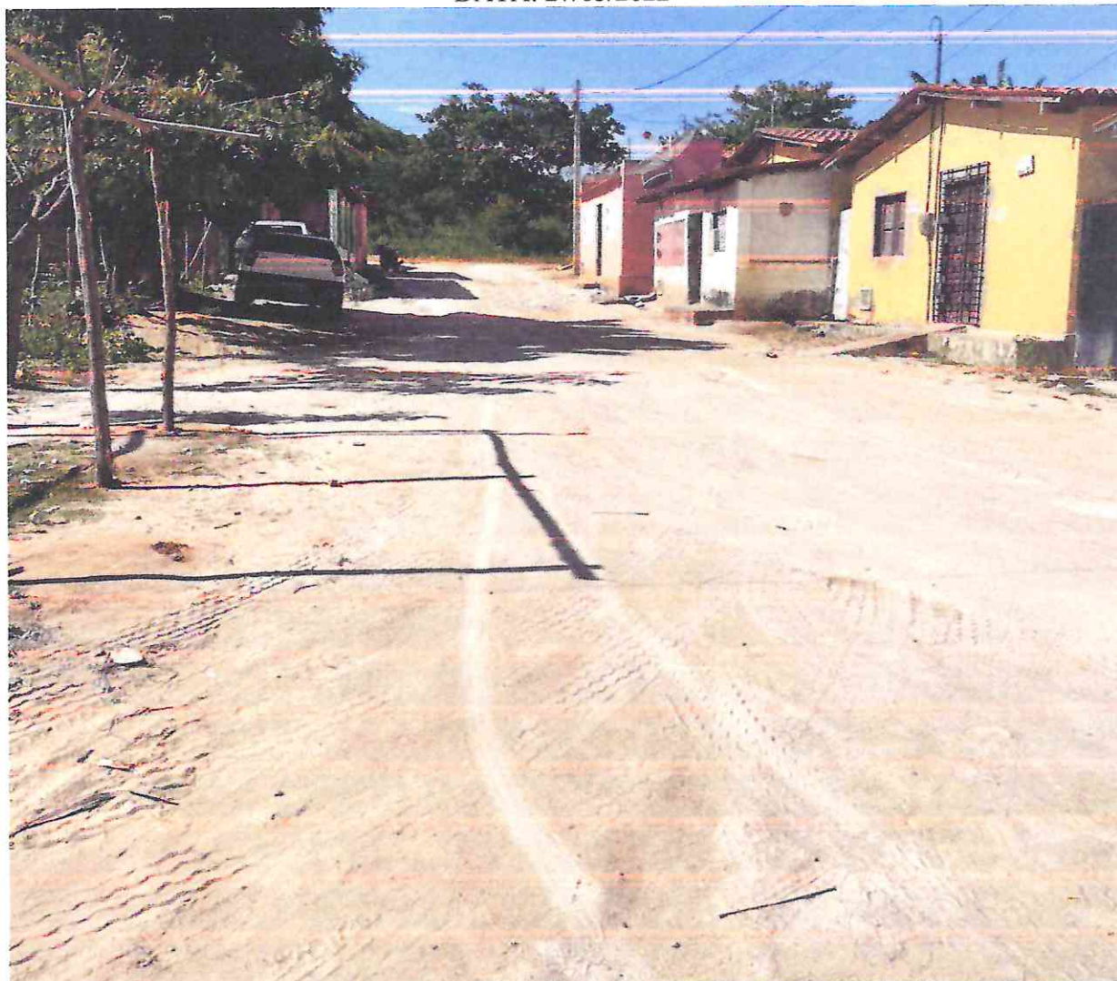
Figura 9: Rua III, Conjunto novo, Jatobá II, Barreira/CE
