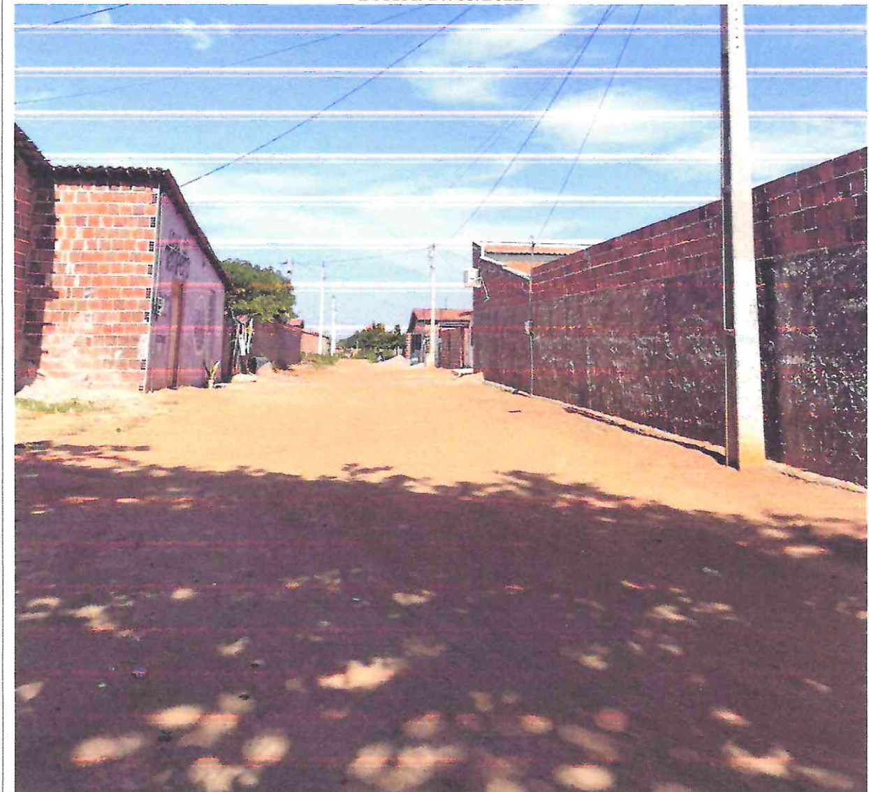
Figura 10: Rua II, Jatobá III, Barreira/CE
