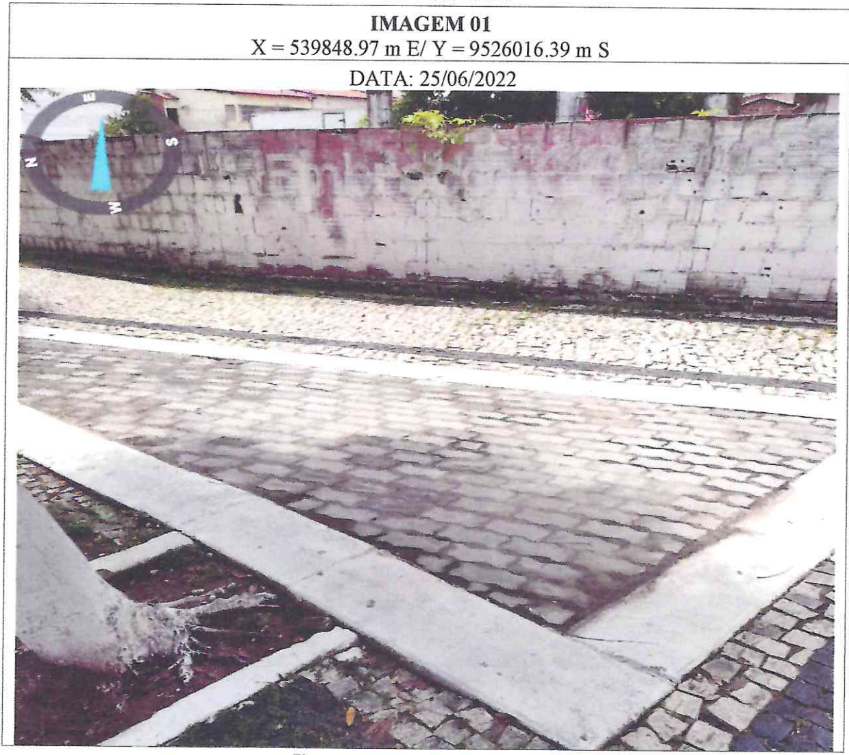
Figura 1: imagens do local da obra
