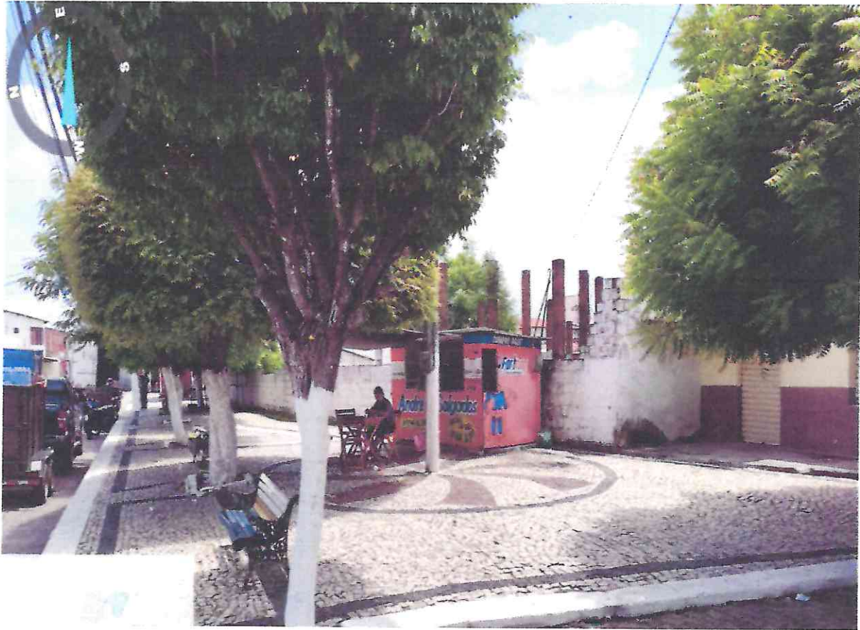
Figura 3: imagens do local da obra
