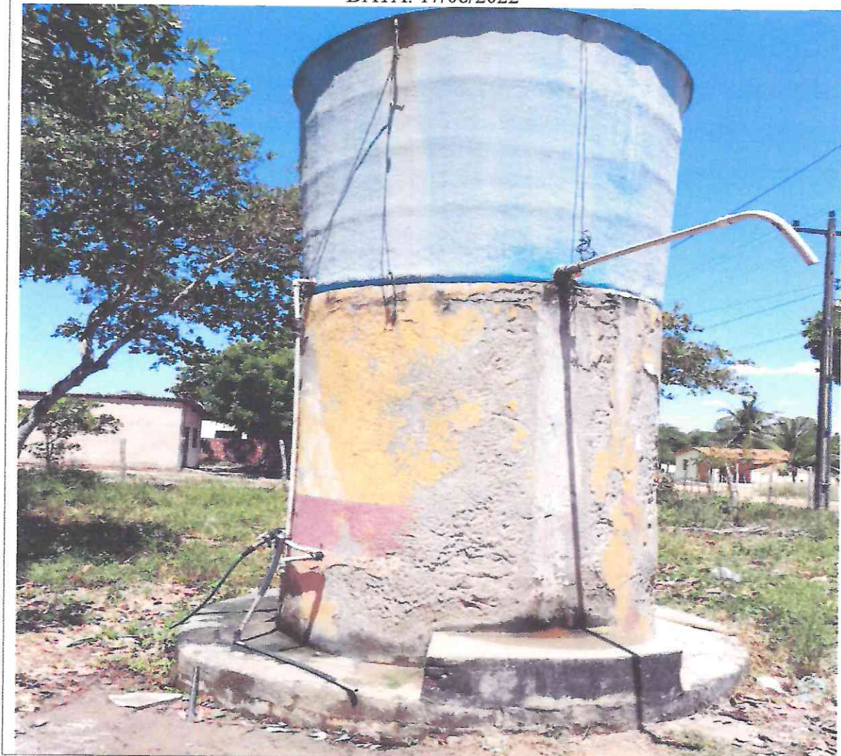
Figura 7: imagens do local da obra
