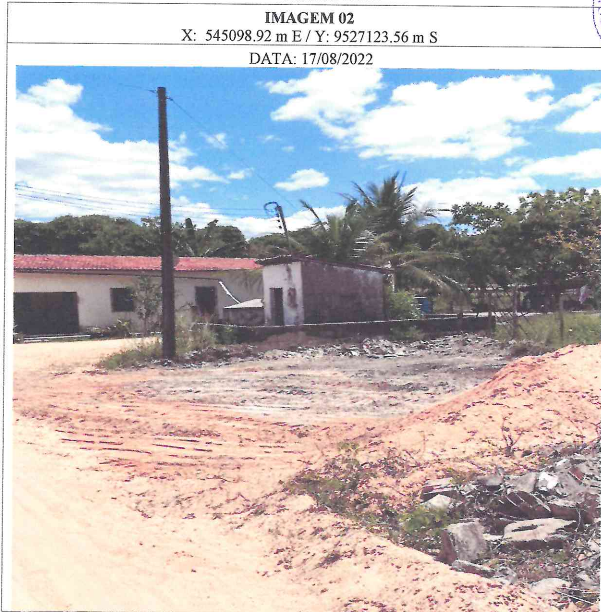
Figura 2: imagens do local da obra
