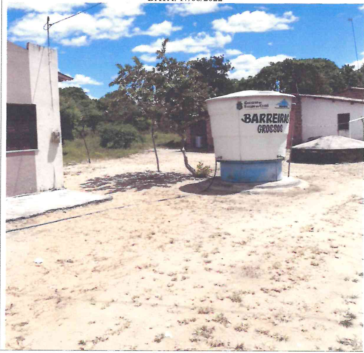
Figura 3: imagens do local da obra
