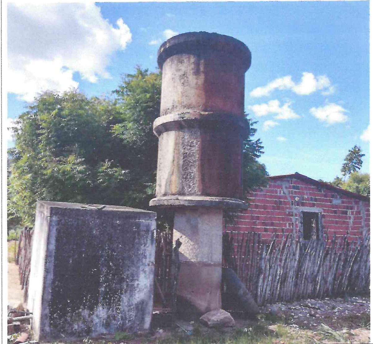
Figura 13: imagens do local da obra
