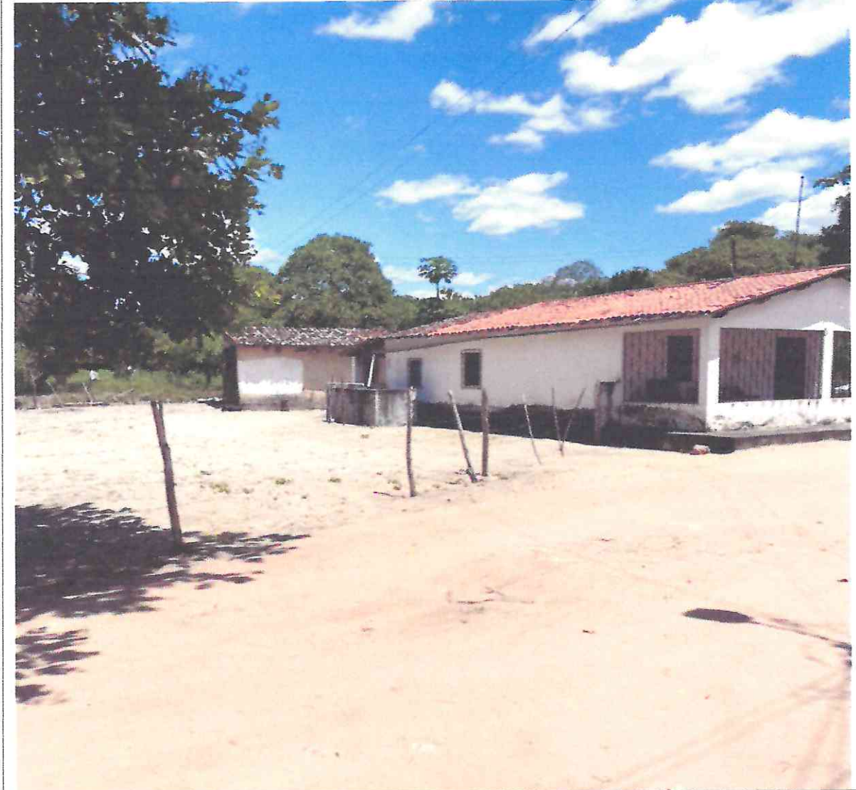
Figura 12: imagens do local da obra
