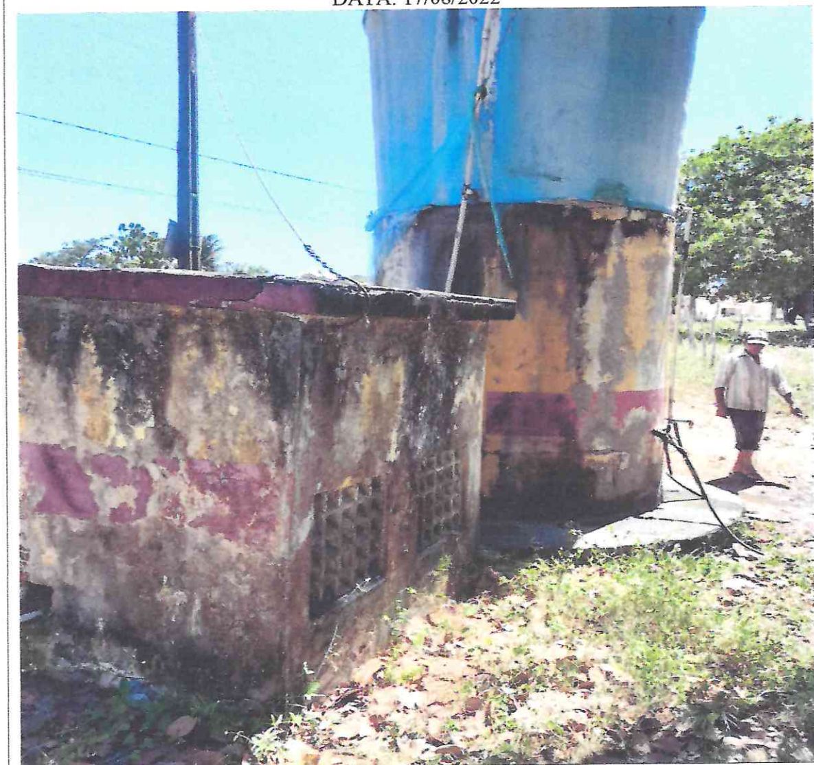
Figura 8: imagens do local da obra
