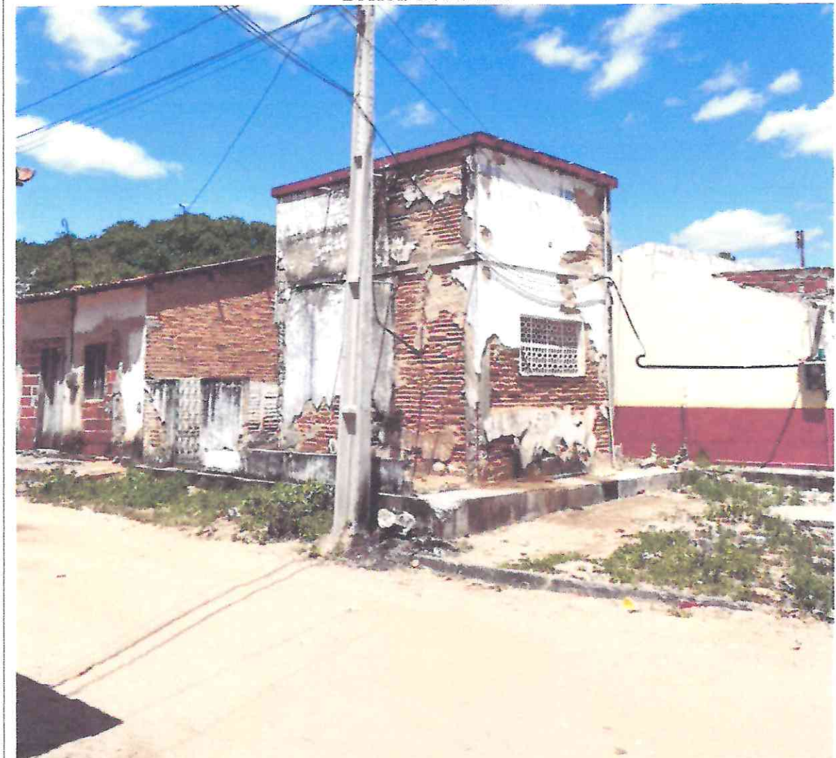
Figura 10: imagens do local da obra
