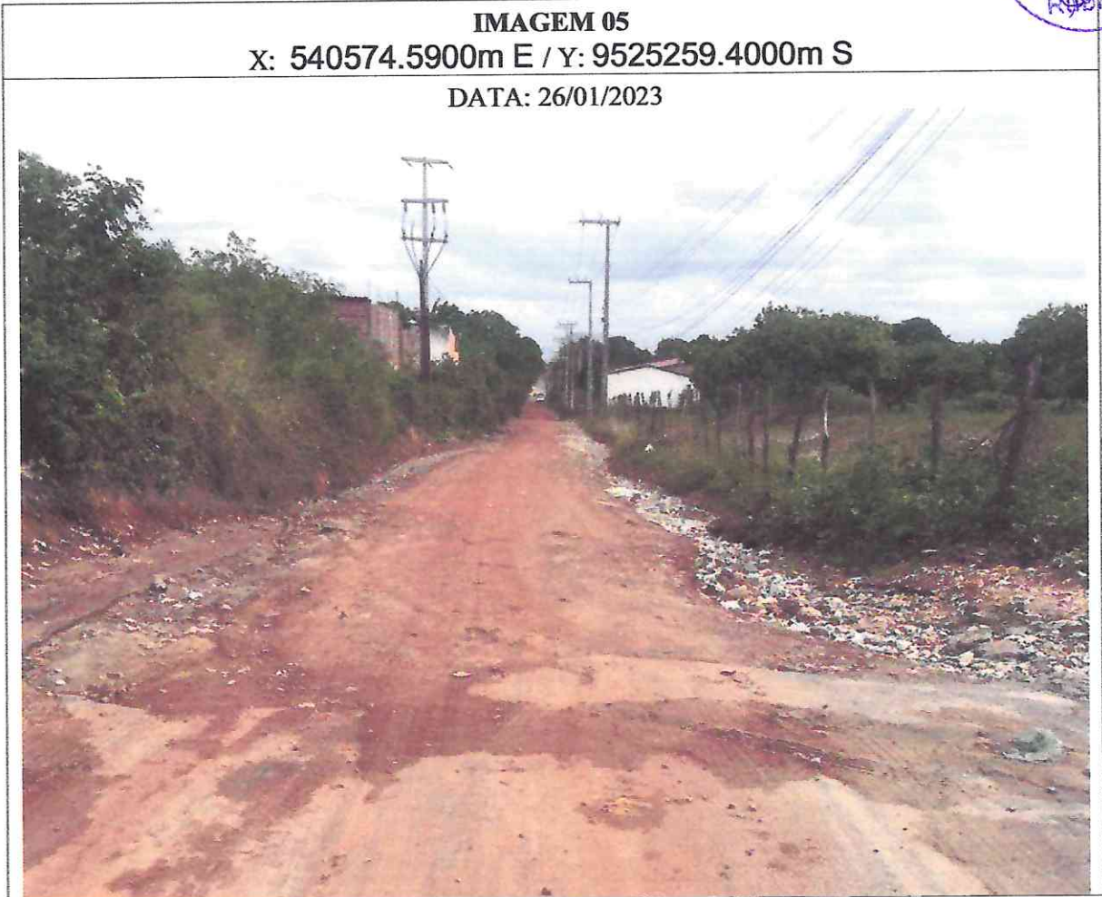
Figura 5: imagens do local da obra
