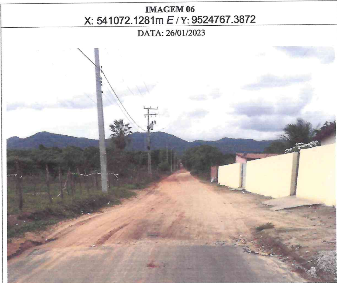
Figura 6: imagens do local da obra
