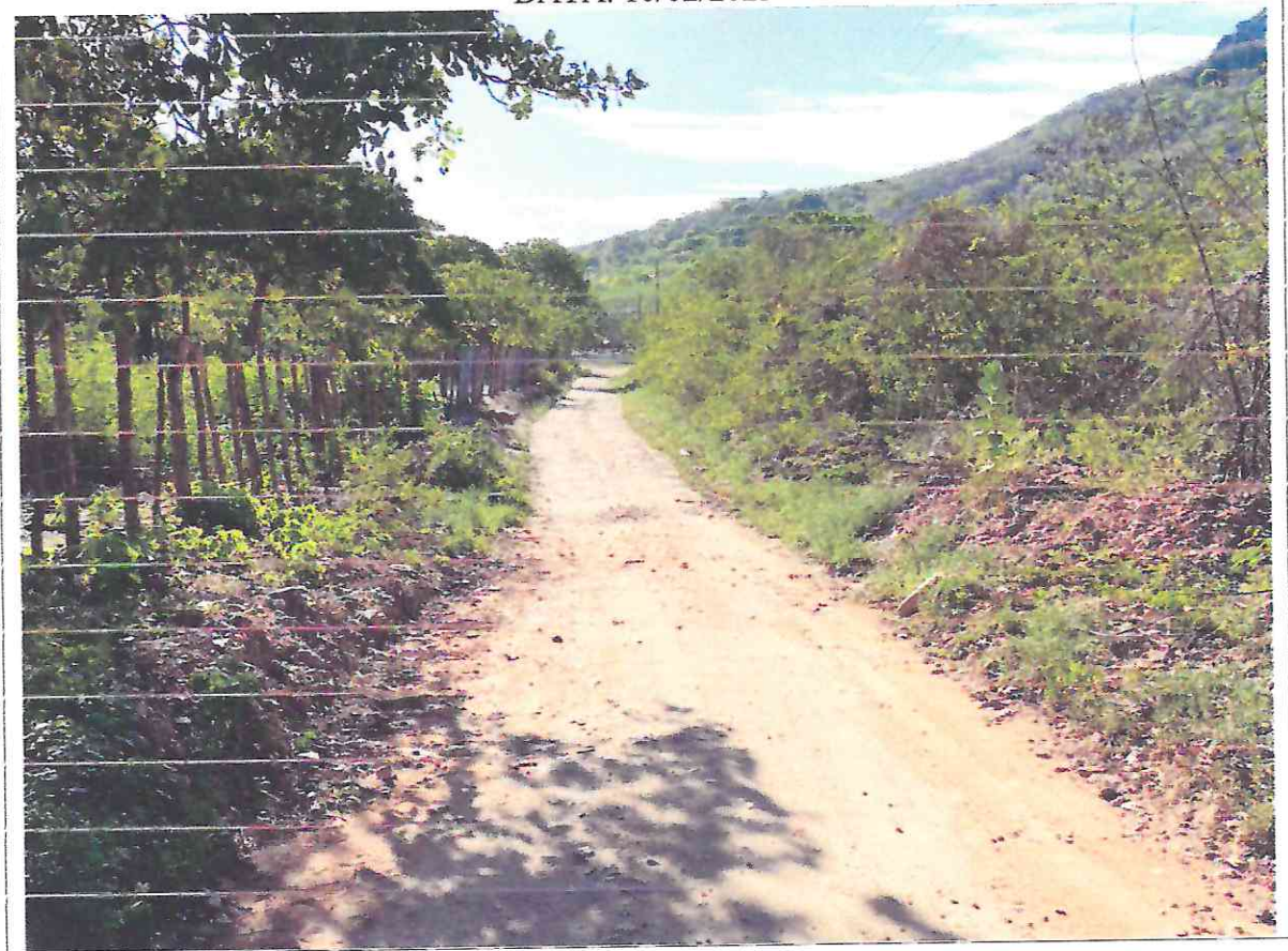
Figura 1: imagens do local da obra
