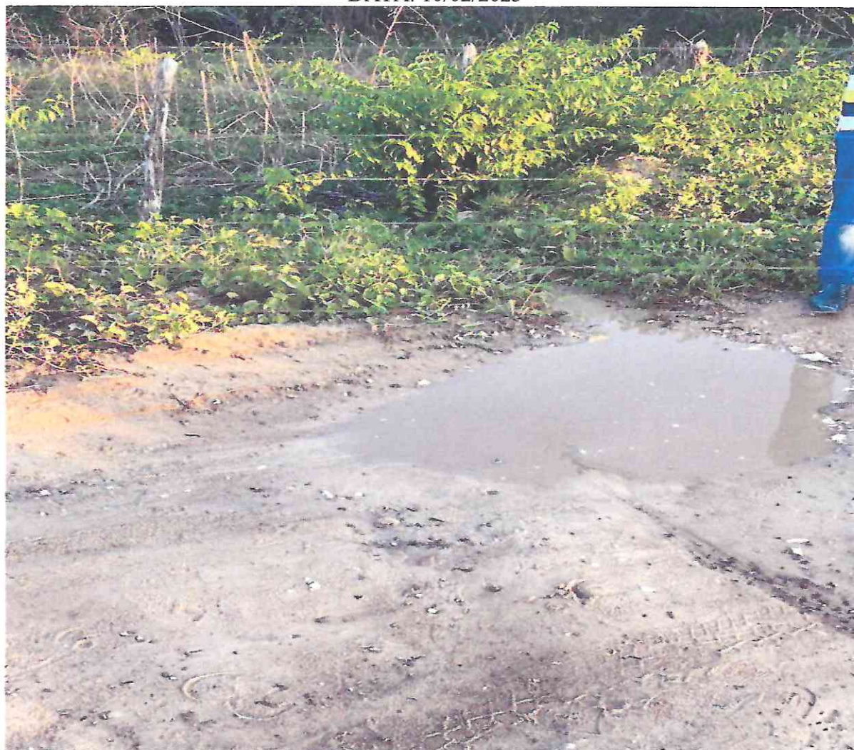
Figura 7: imagens do local da obra
