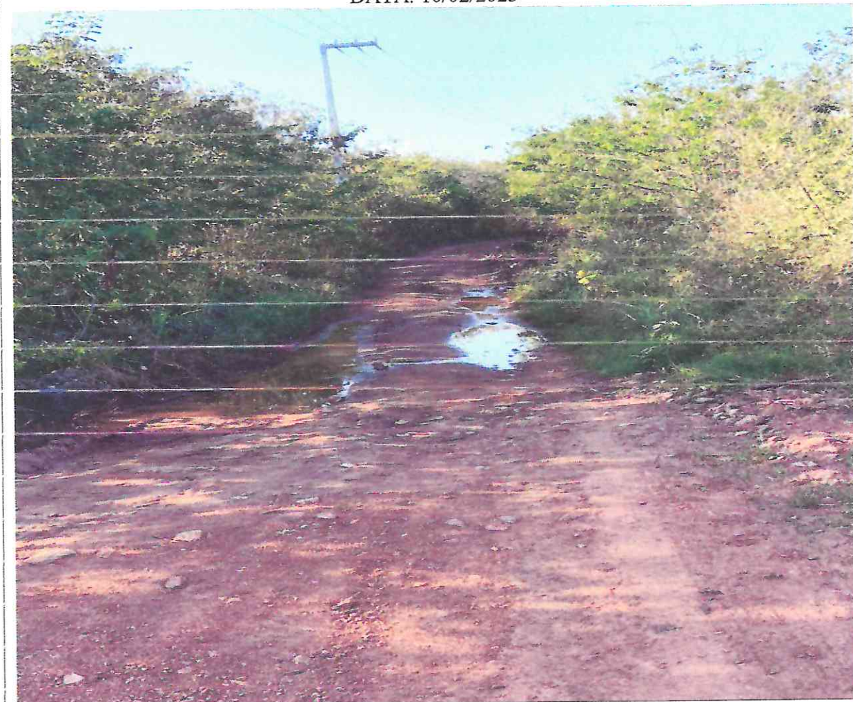
Figura 4: imagens do local da obra
