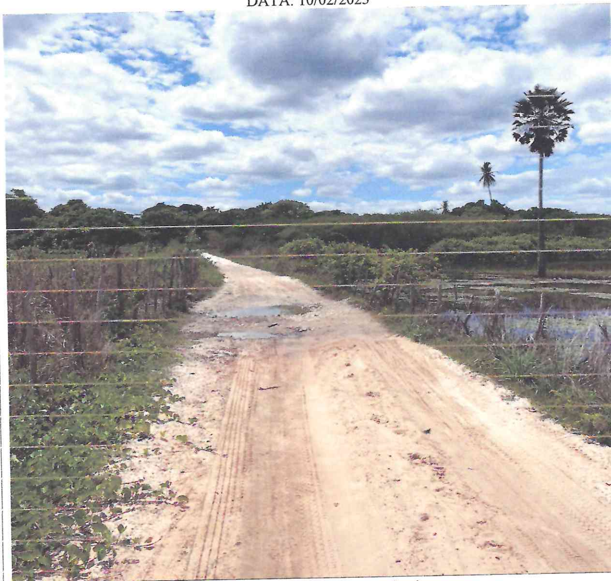
Figura 11: imagens do local da obra
