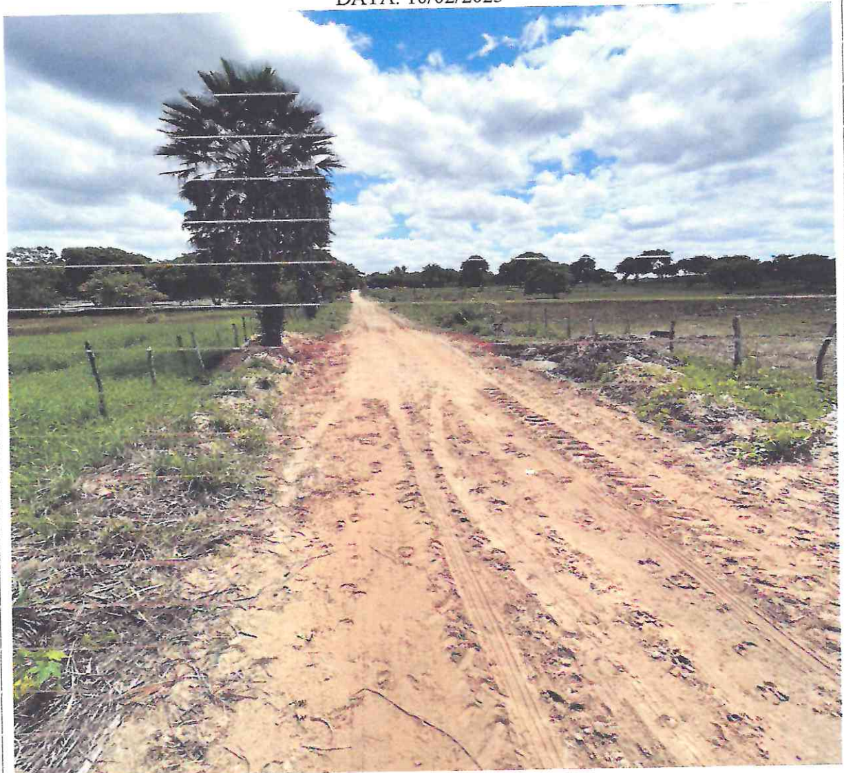
Figura 12: imagens do local da obra
