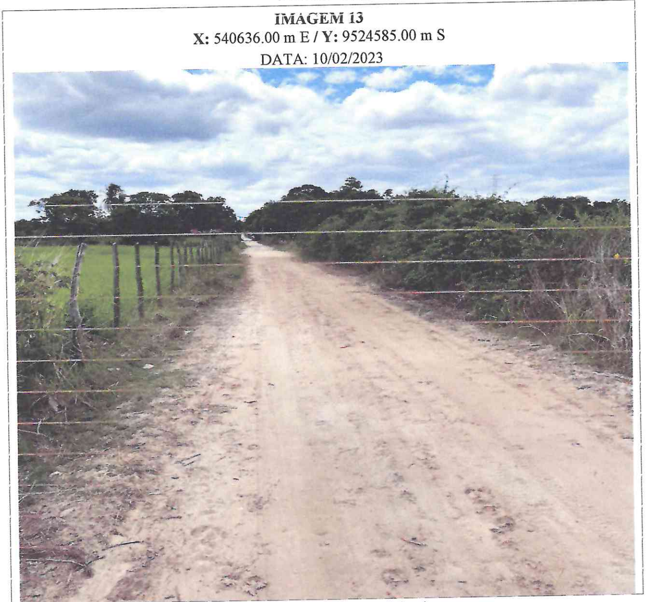
Figura 13: imagens do local da obra
