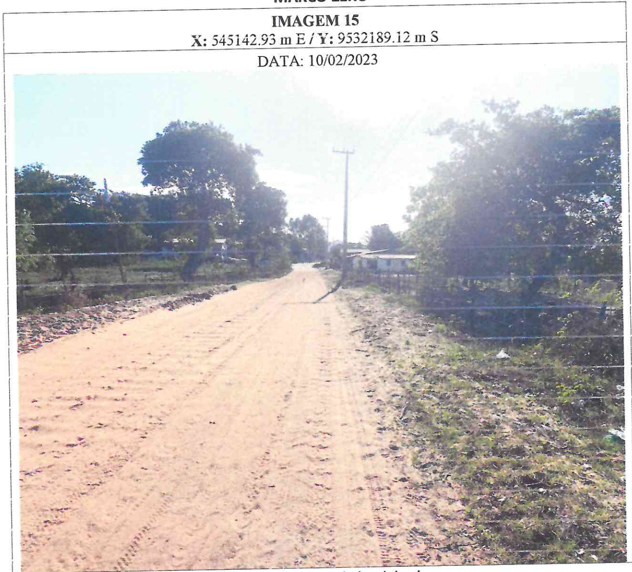
Figura 15: imagens do local da obra
